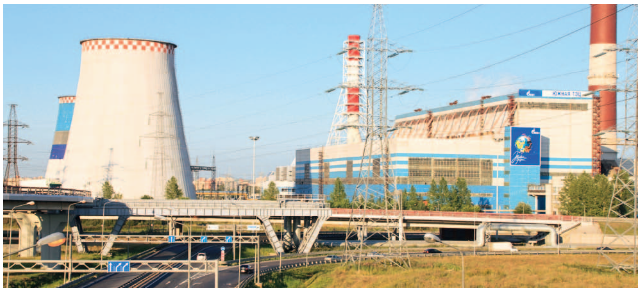
Россия, г. Москва, электростанция, 7 000 м 2
