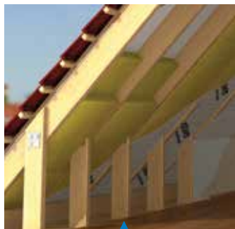
Теплоізоляція розміщена в міжкряквяному просторі.
